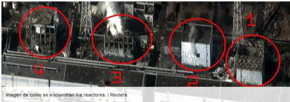
Figura 4: Imagen de los reactores dañados al 17 de marzo del 2011
